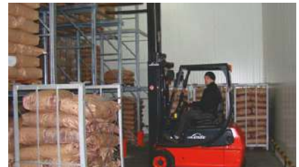
РЕКОНСТРУКЦІЯ: ЦЕХ ЗАМОРОЗКИ Darlissad Ltd Волинська обл., 2018
