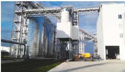
РЕКОНСТРУКЦІЯ: СУШИЛЬНИЙ ЦЕХ ТОВ «УХЛК» Житомирська обл., 2018
