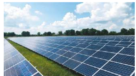
СОНЯЧНА ЕЛЕКТРОСТАНЦІЯ ООО «Сонячна брама» Івано-Франківська обл. 2018
